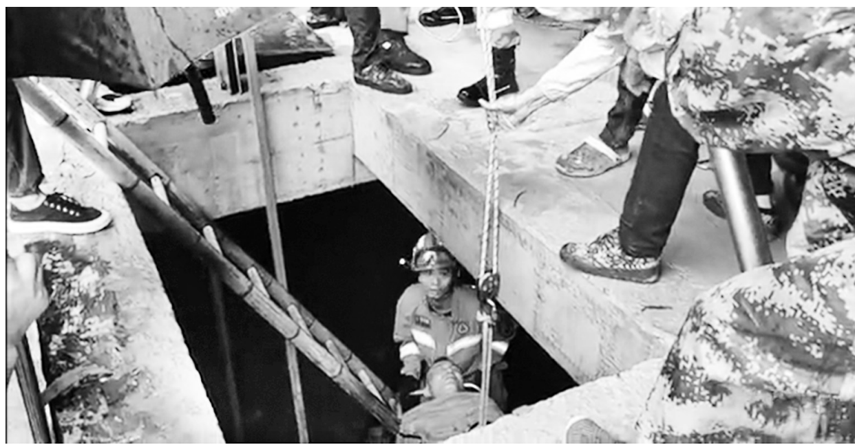
消防救援人员将被困工人救起
